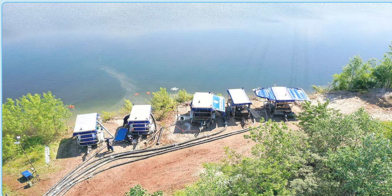
Abpumpen des Wassers in den Schauffele-Baggersee.
